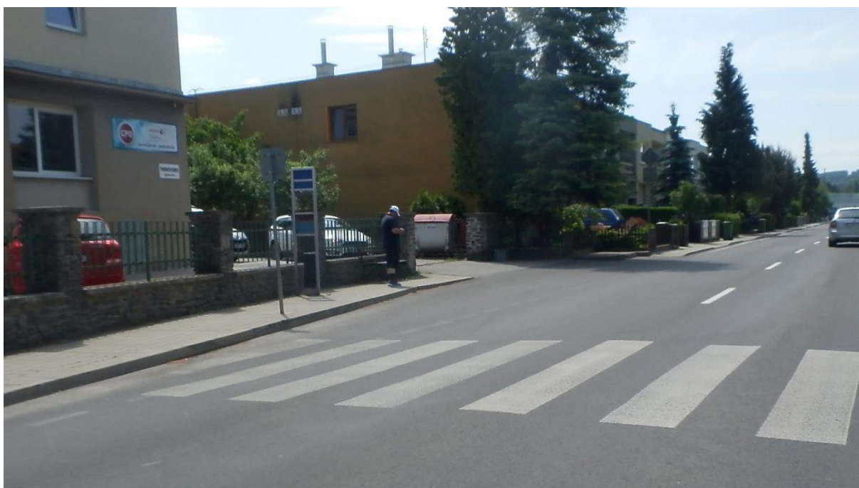
Obr. 4-29 Nekrytá zastávka Na Karlove
