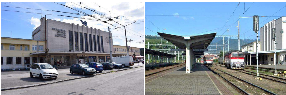
Obr. 4-38 Budova železničnej stanice a nástupište
