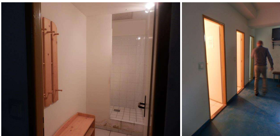
Obr. 3-5 Kúpeľne v budove MsÚ BB
