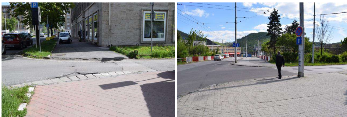
Obr. 4-26 Nedostatočne debarierizované priechody pre chodcov
