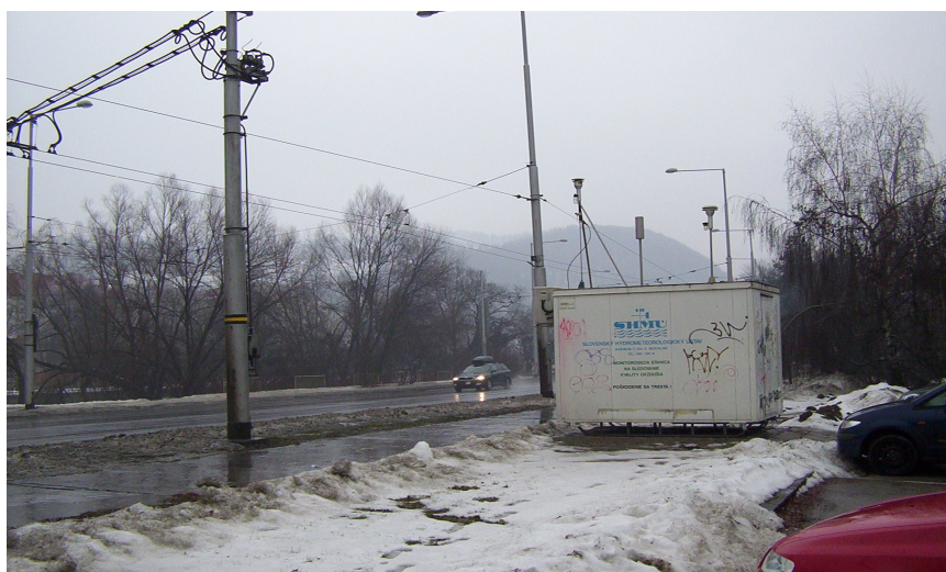
Obr. 1 Automatická monitorovacia stanica
