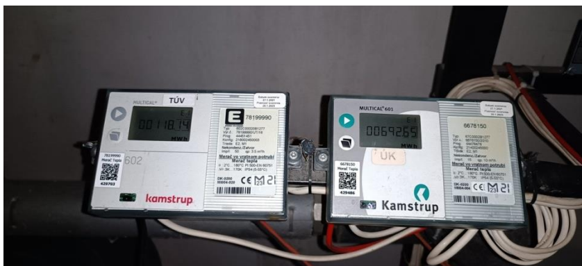
Obrázok 13. Fakturačné merače tepla ÚK a TV
