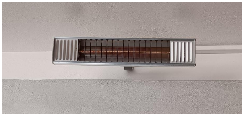
Obrázok 18. Elektrický sálavý panel
