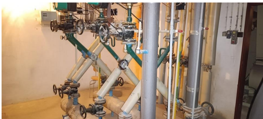
Obrázok 15. Rozdeľovač a zberač
