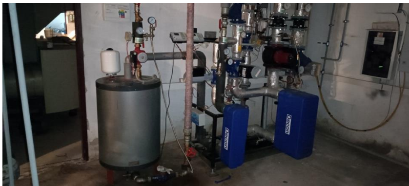
Obrázok 15. Rozdeľovač a zberač
