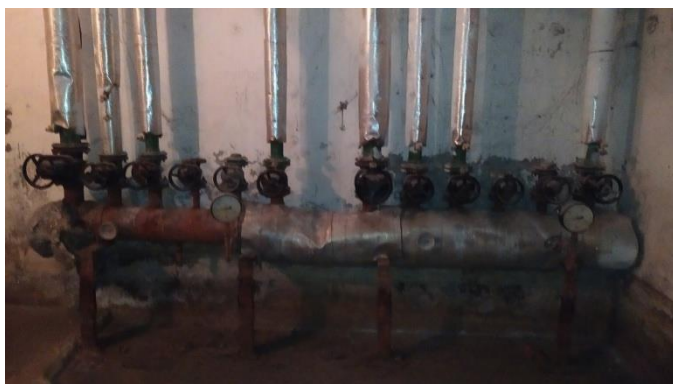
Obrázok 14. Rozdeľovač a zberač ÚK
