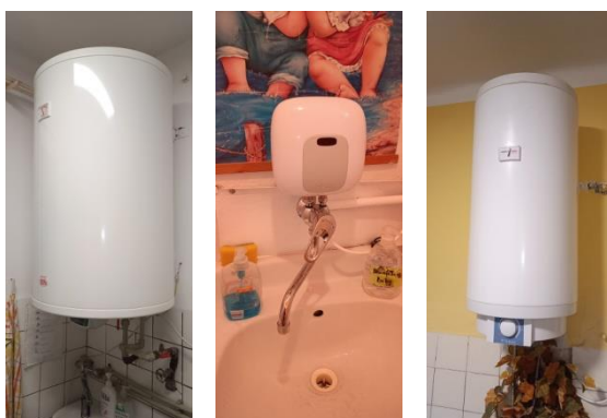
Obrázok 11. Elektrické ohrievače teplej vody
