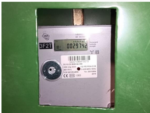
Obrázok 8. Fakturačný elektromer
