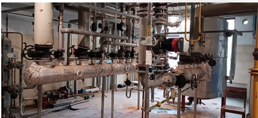
Obrázok 32. Rozdeľovač a zberač pri strojovni VZT
