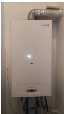
Obrázok 26. Plynový kotol v byte
