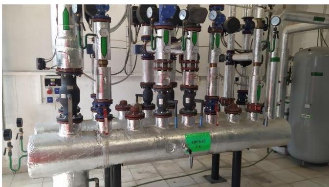
Obrázok 22. Rozdeľovač a zberač ÚK
