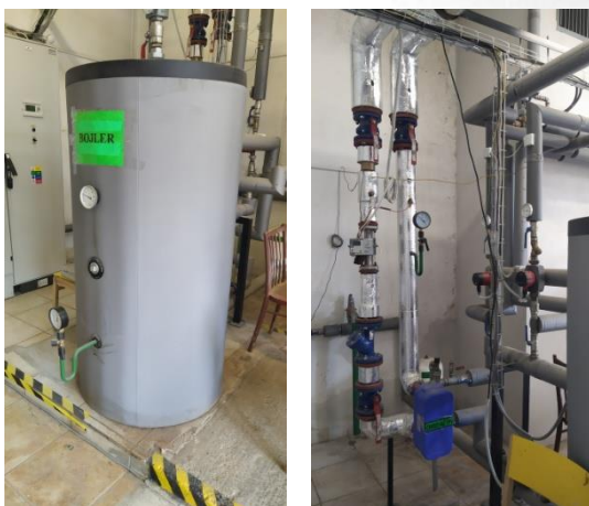
Obrázok 25. Zásobníkový ohrievač, doskový výmenník v PK
