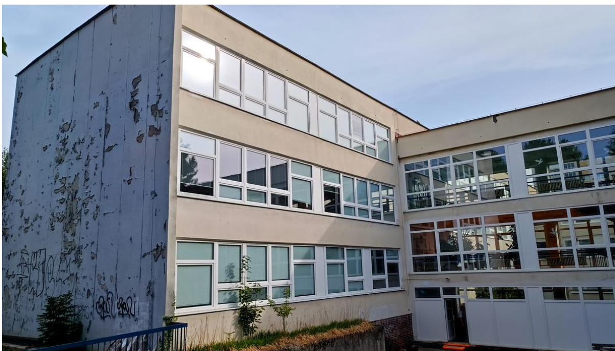
Obrázok 30. Základná škola – blok C – pohľad II.
