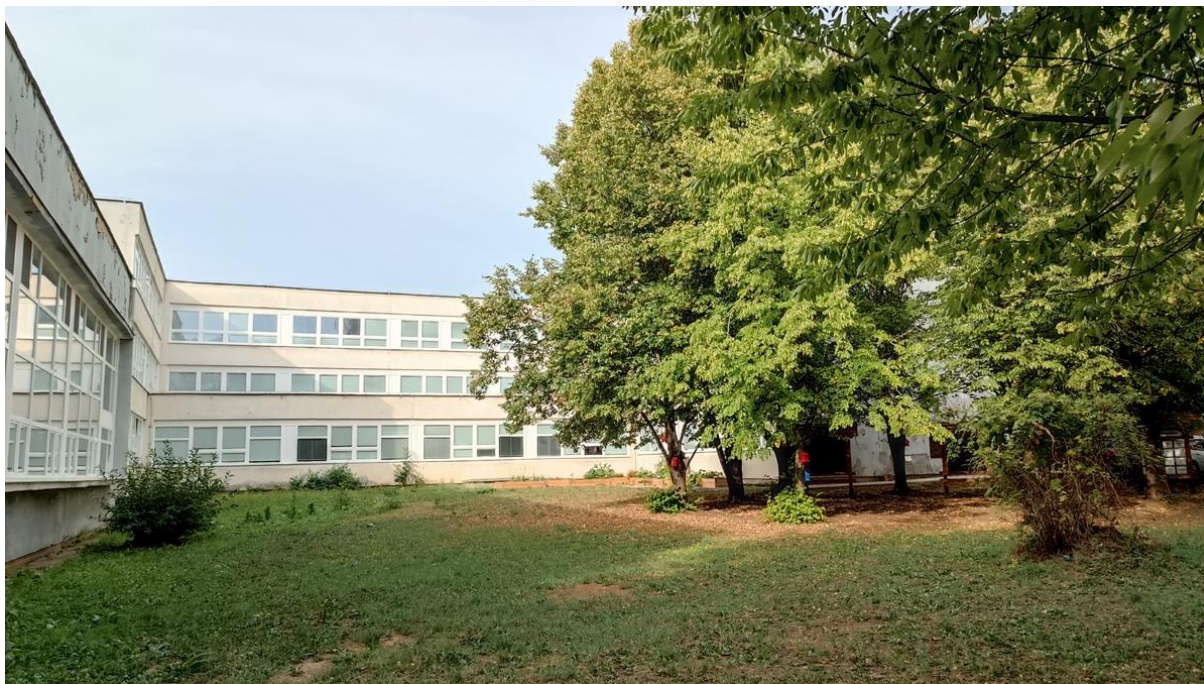
Obrázok 34. Základná škola – blok F - pohľad I.
