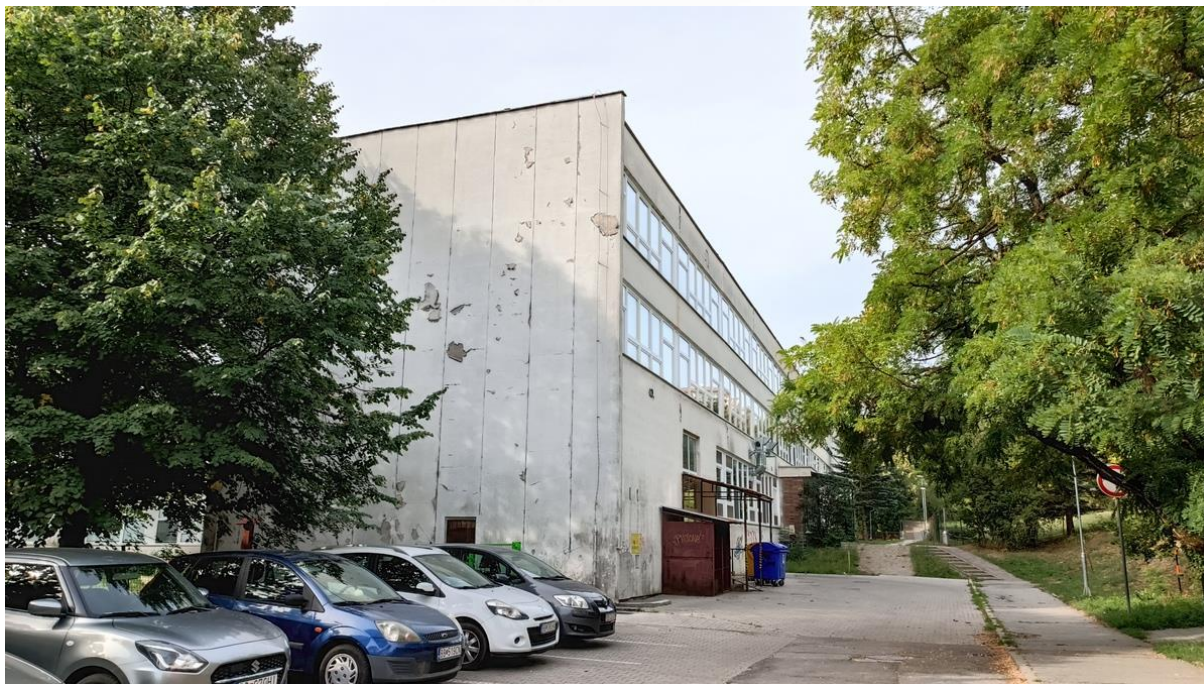
Obrázok 31. Základná škola – blok D - pohľad I.
