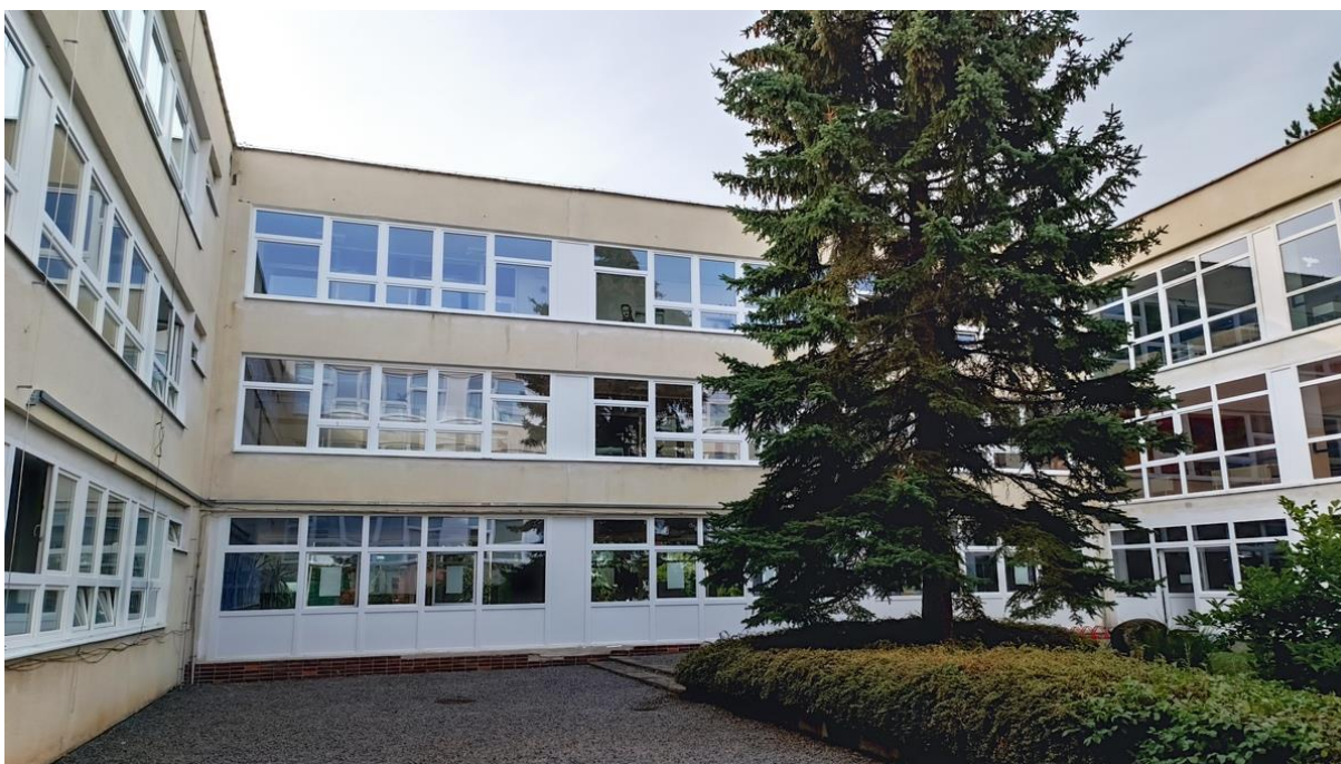
Obrázok 28. Základná škola – blok B - pohľad II.
