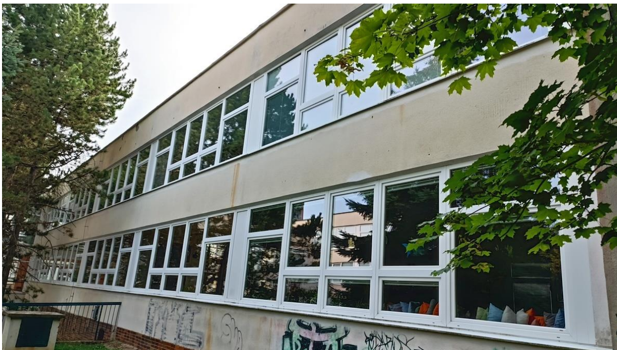
Obrázok 26. Základná škola – blok A - pohľad II.
