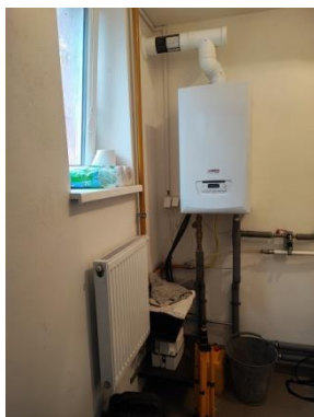
Obrázok 11. Závesný plynový kotol v priestoroch hasičskej zbrojnice
