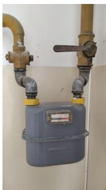
Obrázok 22. Fakturačný plynomer pre kuchyňu ZŠ
