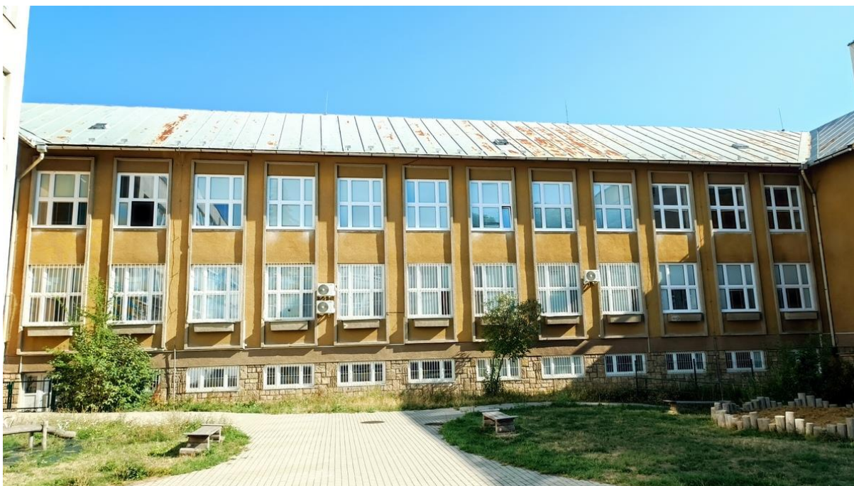
Obrázok 34. Základná škola – blok A - pohľad II.
