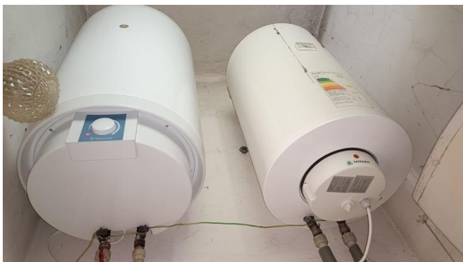
Obrázok 27. Elektrické ohrievače v bloku A
