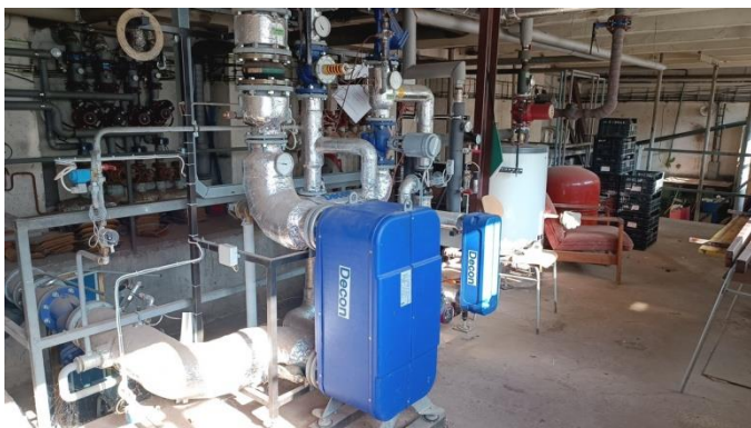
Obrázok 24. Rozdeľovač a zberač ÚK
