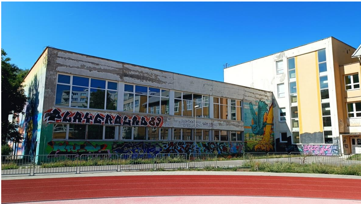
Obrázok 39. Základná škola – blok D - pohľad I.
