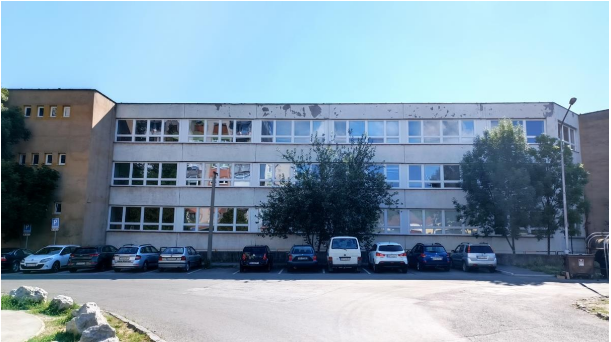
Obrázok 37. Základná škola – blok C - pohľad I.
