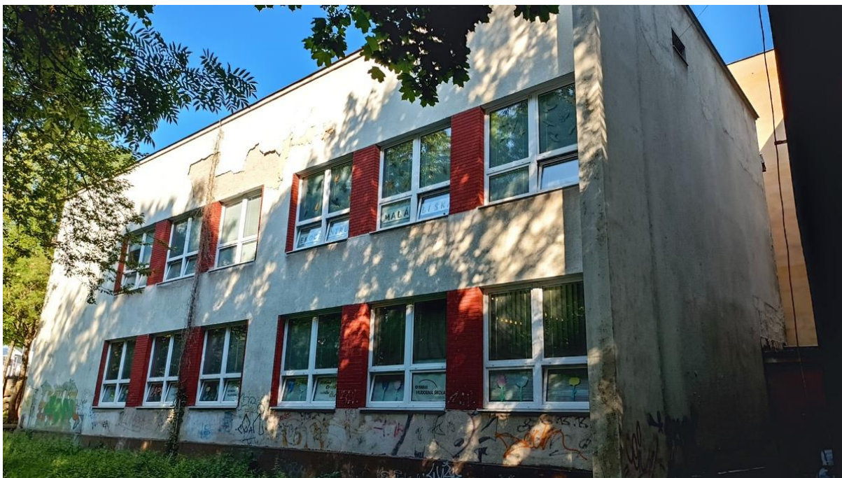
Obrázok 36. Základná škola – blok B - pohľad II.
