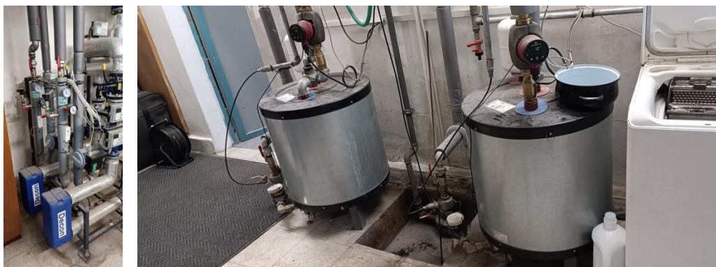
Obrázok 28. Doskové výmenníky, zásobníkové ohrievače
