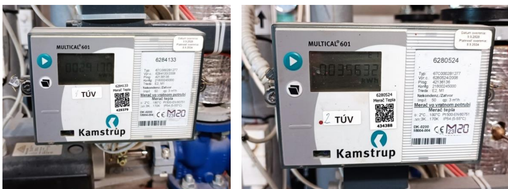
Obrázok 25. Dva fakturačné merače tepla pre TV (škola a kuchyňa)
