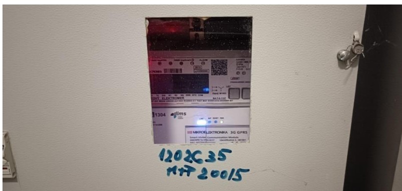
Obrázok 23. Fakturačný elektromer pre kuchyňu
