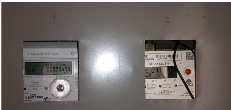
Obrázok 23. Fakturačný elektromer pre kuchyňu
