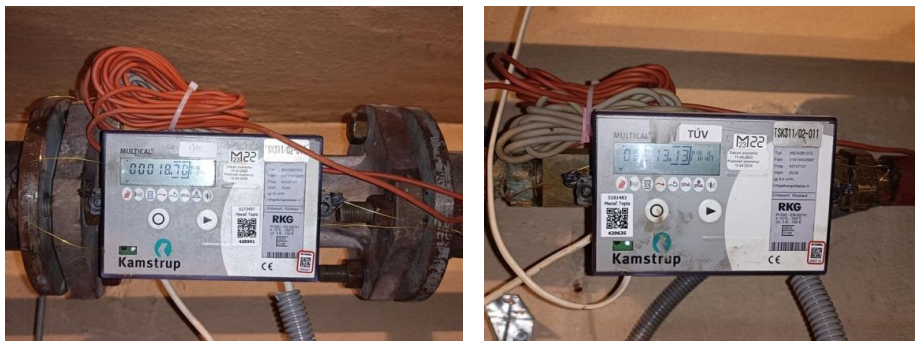
Obrázok 20. Fakturačné merače tepla pre ÚK a TV
