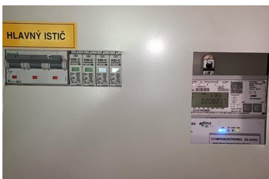
Obrázok 19. Fakturačný elektromer pre kuchyňu
