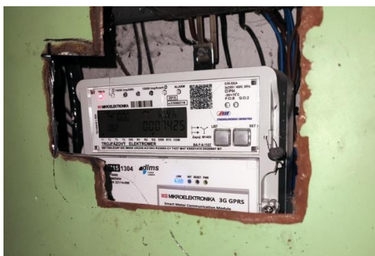
Obrázok 19. Fakturačný elektromer pre kuchyňu
