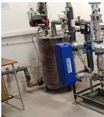
Obrázok 19. Doskový výmenník, zásobníkový ohrievač
