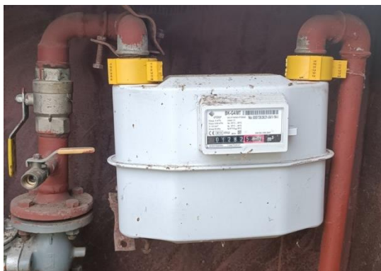
Obrázok 16. Fakturačný plynomer
