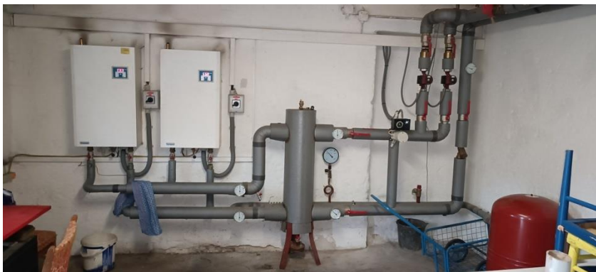
Obrázok 7. Technologické zariadenia kotolne
