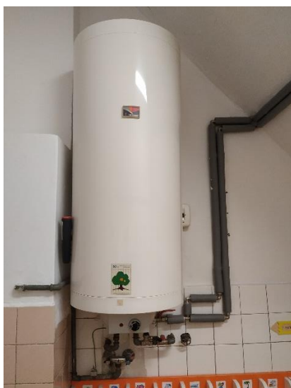
Obrázok 10. Zásobníkové ohrievače
