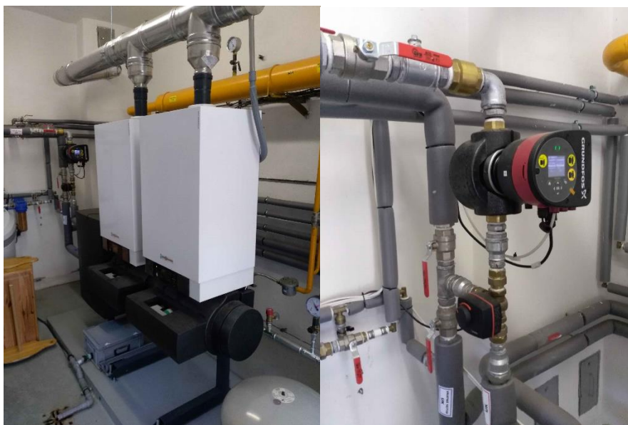
Obrázok 10. Kotle a obehové čerpadlo
