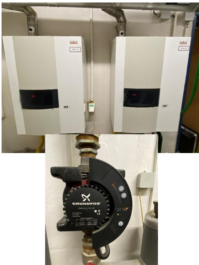
Obrázok 12. Kotle a obehové čerpadlo
