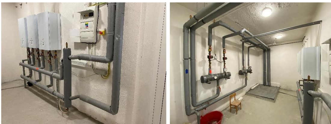
Obrázok 8. Kotle a rozdeľovač ÚK
