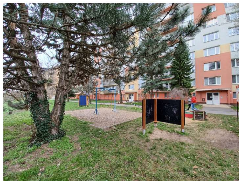
NEDOSTAČNÝ A ZLÝ TECHNICKÝ STAV NIEKTORÝCH HERNÝCH PRVKOV PODĽA AKTUÁLNYCH NORIEM
