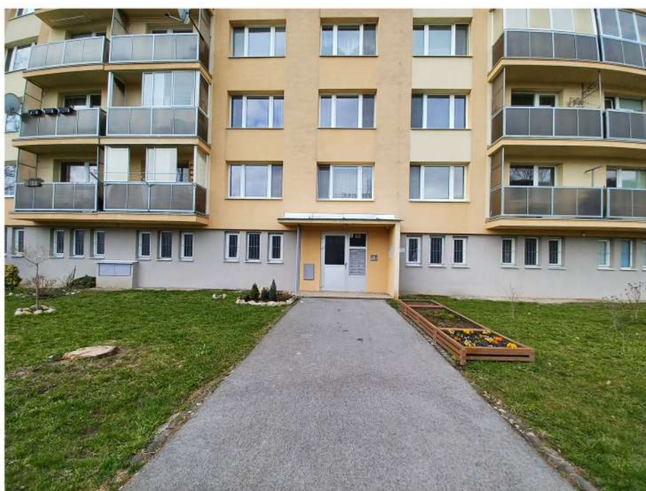
NEVHODNOSŤ ŠTÝLU POUŽITÝCH VEGETAČNÝCH PRVKOV PRI VSTUPE DO BYTOVÉHO DOMU
