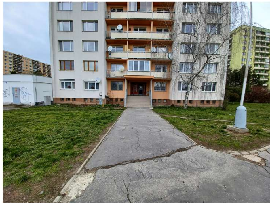
BARIÉROVÉ VSTUPY DO BYTOVÝCH DOMOV DOPLNIŤ RAMPOVÝM SYSTÉMOM Z DRUHEJ STRANY
