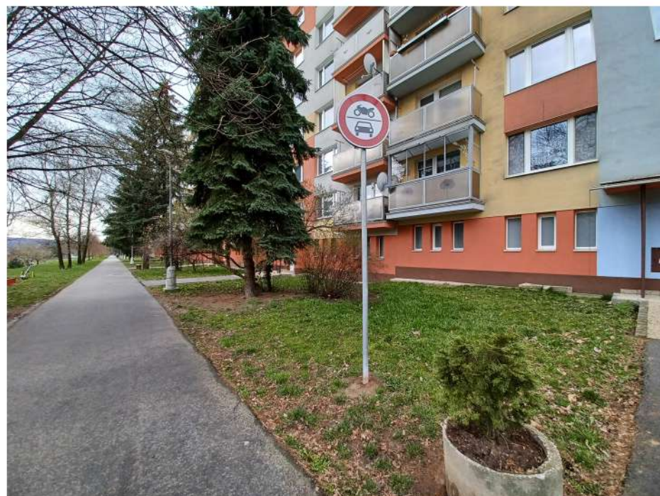
PRÍTOMNOSŤ IHLIČNANOV V BLÍZKOSTI FASÁDY SPÔSOBUJE VÝRAZNE ZATIENENIE OKIEN A NARUŠENIE STATIKY BUDOVI
