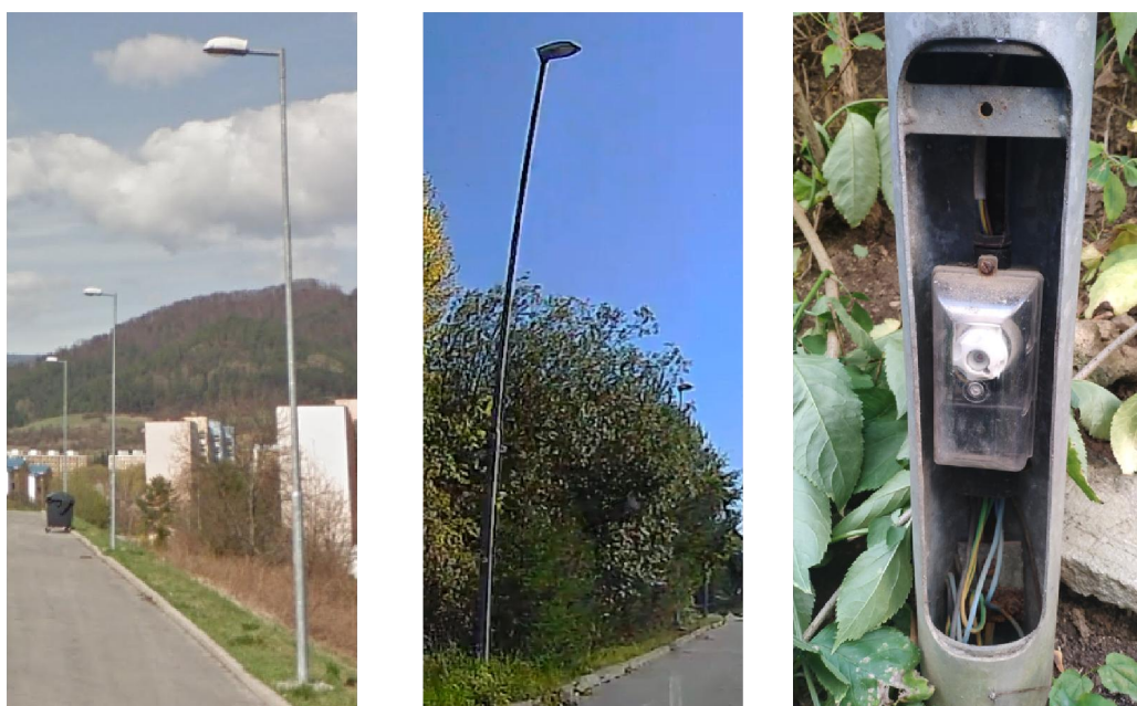
Obr. 12 Žiarovo zinkované stožiare – Ulica Šalgotárjanska, Jazmínova, Švermová 1-17
