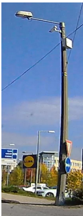
Betónový trakčný stožiar Ulica Švermova
