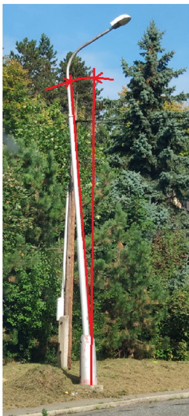
Obr. 5 Ulica Poľná a Ulica Hutná - Krivé stožiare
