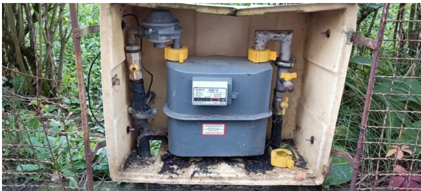
Obrázok 14. Fakturačný plynomer pre kuchyňu MŠ
