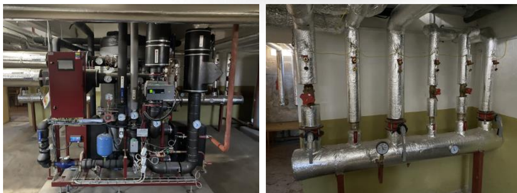
Obrázok 12. KOST a rozdeľovač ÚK
